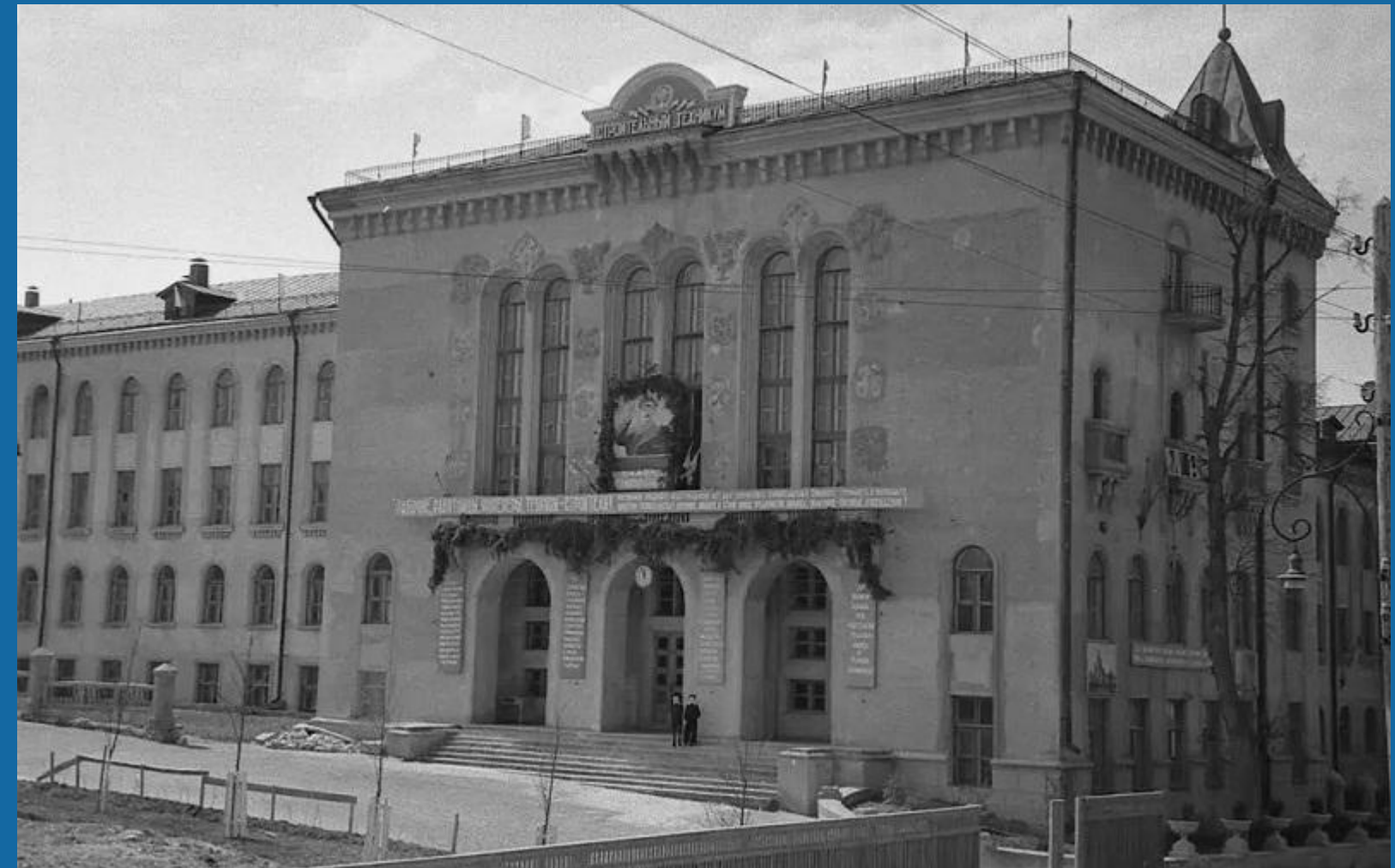
Строительный техникум, 1952 год.
